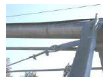
Befestigung des ersten Turms
